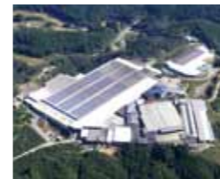
日本 三重県南牟婁郡 製品名 CS6P-P システム容量 1MWp 竣工 2012年10月
