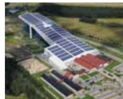
ドイツ ハンブルグ市 製品名 CS6P システム容量3.6MWp 竣工 2012年9月
